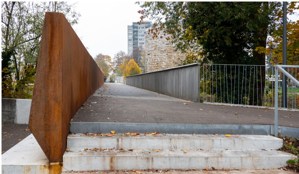
PASSERELLE DU COLLÈGE
