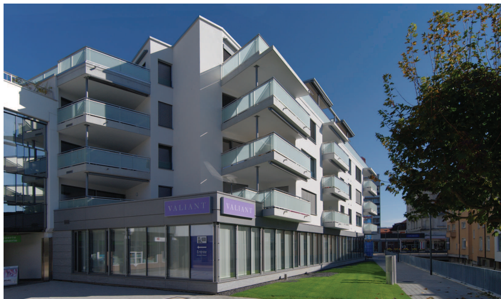
VUE SUD-OUEST DE L'IMMEUBLE
