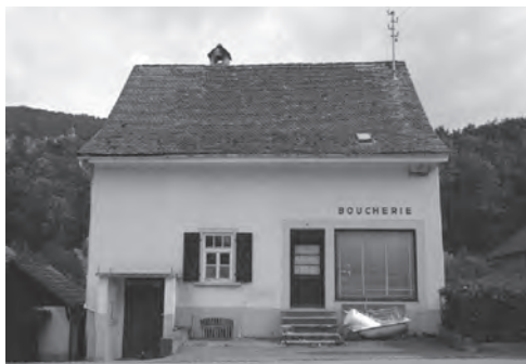
VUE FACADE NORD ETE 2007
