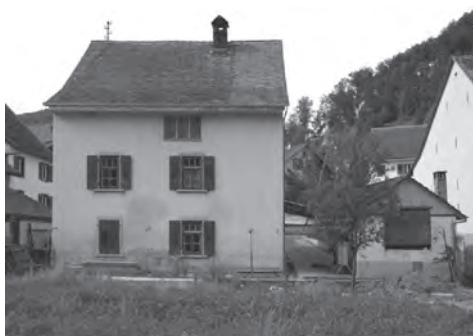
FACADE SUD ETE 2007
